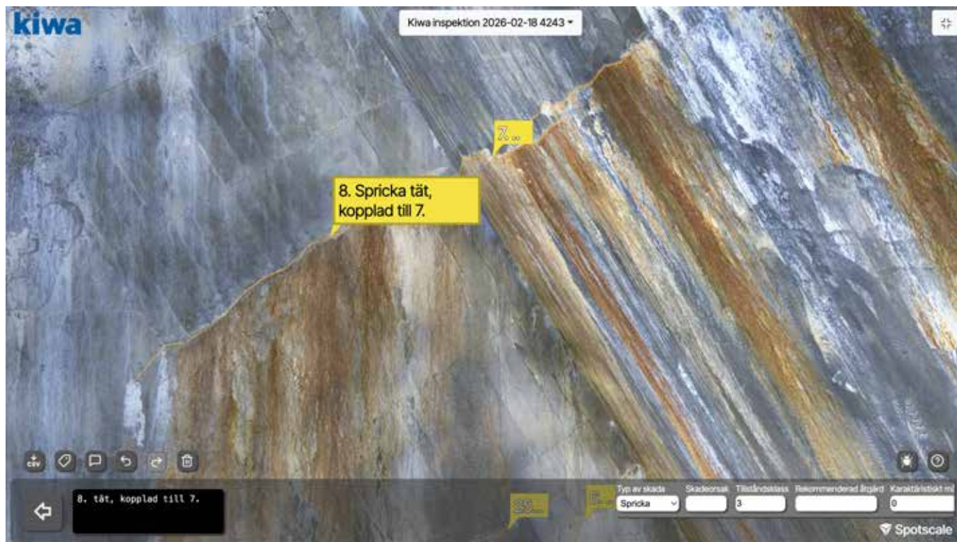
En skärmbild av 3D-verktyget där all data från inspektionen finns tillgänglig. (Foto: Spotscale)
