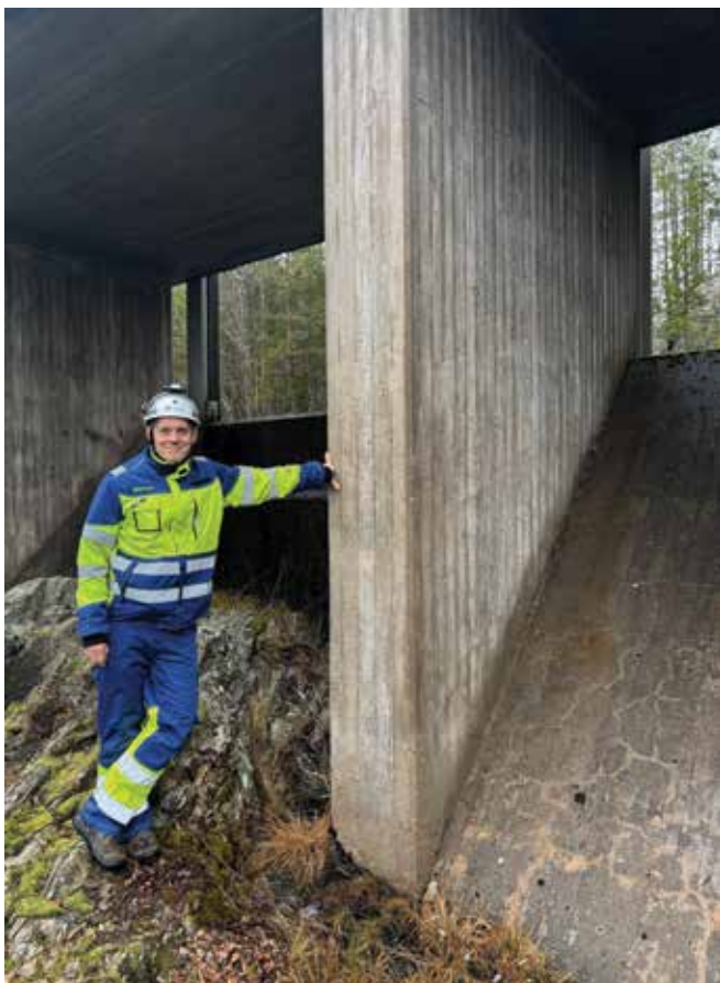
Att arbeta med dammsäkerhet ger ofta möjlighet att komma ut i det fria. Kraftfulla betongkonstruktioner förstärker naturupplevelsen. Foto: Fredrik Gund/Fortum
