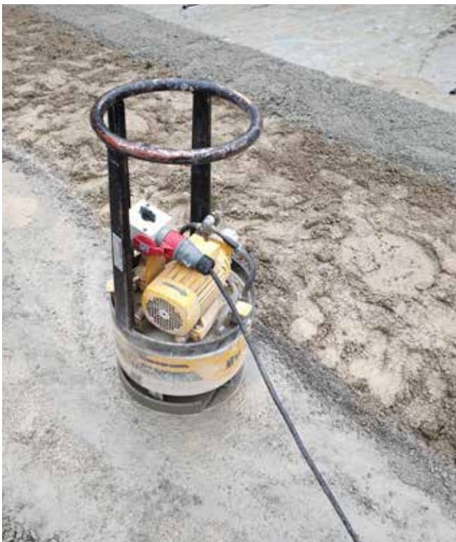
Figur 1. Till vänster: väldigt blöt morän som inte ville samarbeta med packningsutrustningen. Till höger: ett snabbt övergivet försök att torka moränen. Foto: Johan Lagerlund
