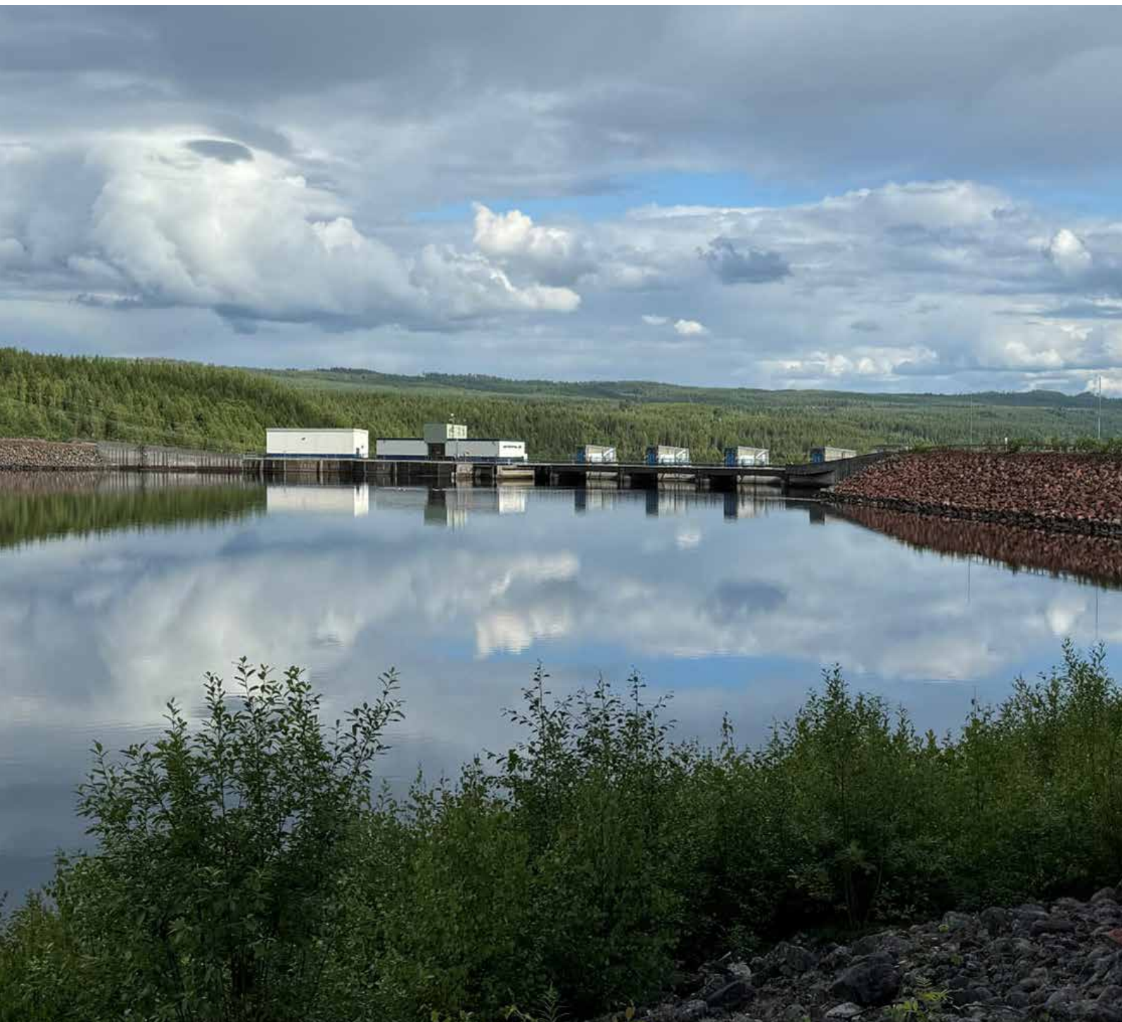
Figur 3. Lågpunkt vid utskov och intag för en dammanläggning. Foto: Peter Viklander
