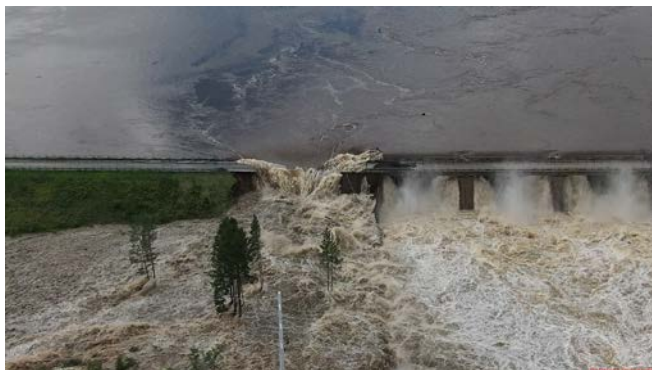
Fyllningsdammarna vid Braskereidfoss överströmmas och havererar. Foto: Politiet i inlandet.
