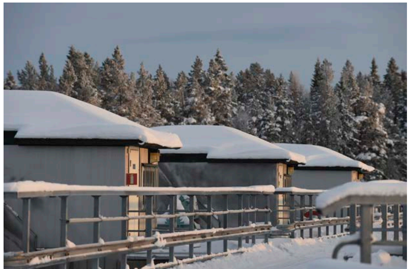
Snö på luckhusen vid Krokströmmen. Foto: Fortum
