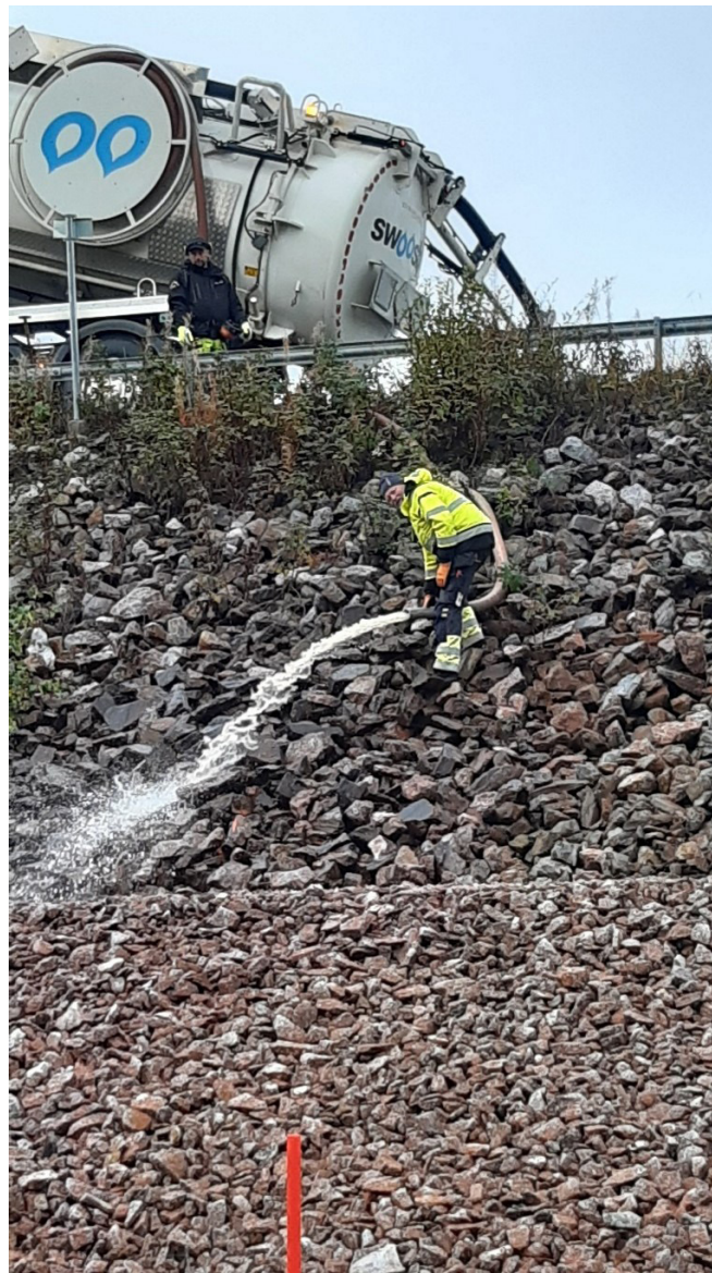
Figur 1. Inpumpning av vatten i stödfyllning.
