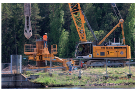
Foderröret monterat och hålls fast av oscillatorn. Kranen förbereder nedsänkning av mejsel i foderrör.
