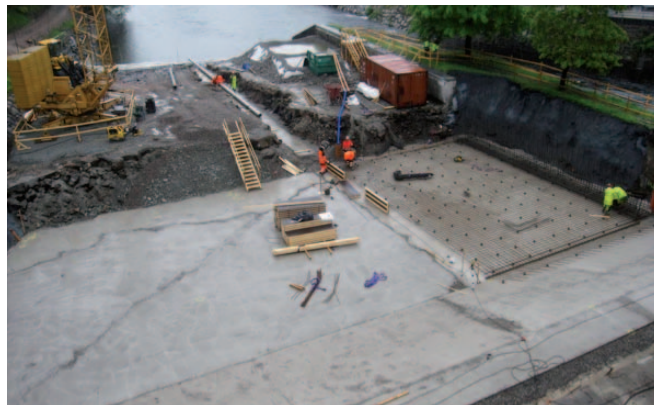
Maj 2013, gjutning av energiomvandlaren. FOTO: Mårten Janz, ÅF.
