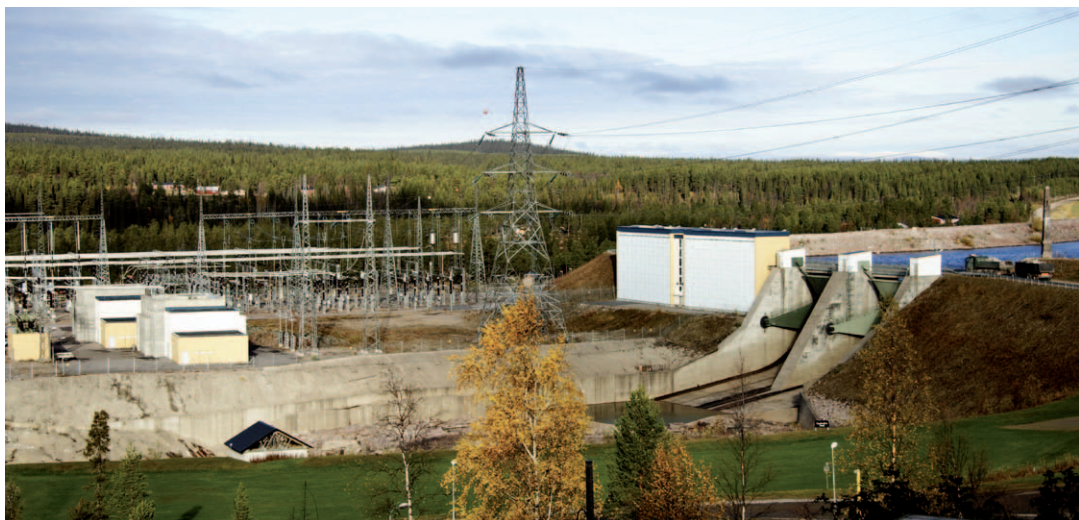
Porjus kraftstation. foto: Hans Blomberg
