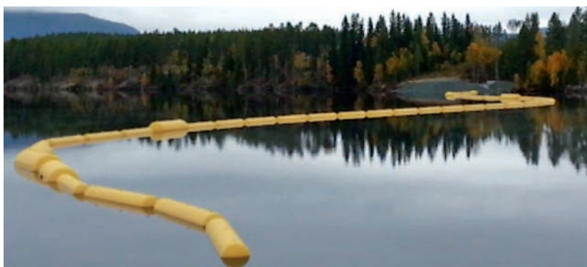
Länsan under installation, hösten 2012. Länsan är ännu inte uppspänd.
