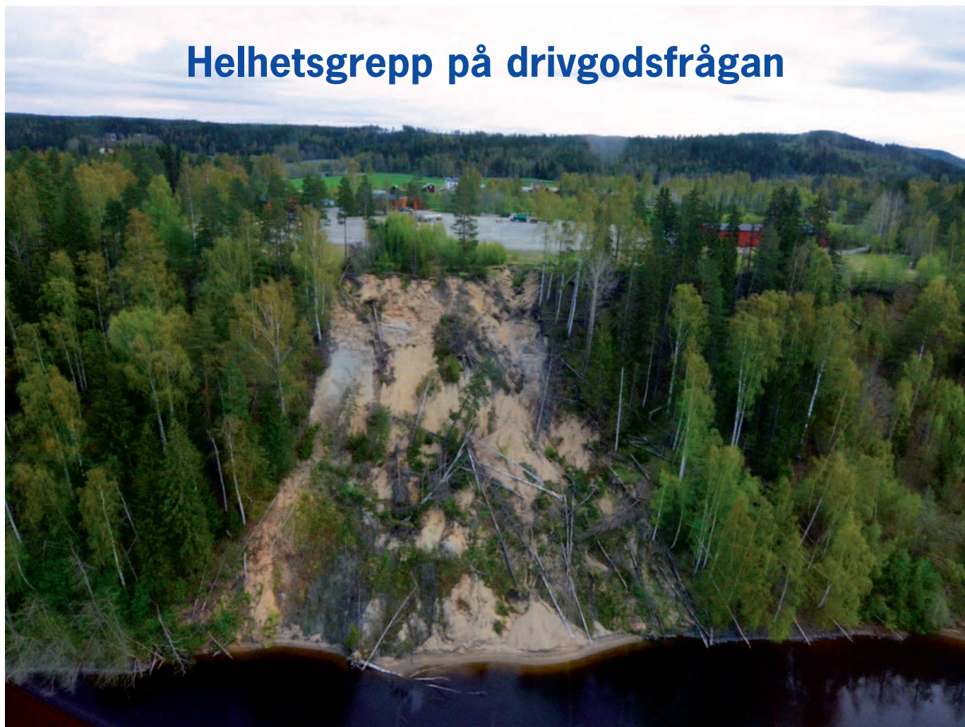
Nipras uppströms Sollefteå kraftverk. Foto: Stina Åstrand
