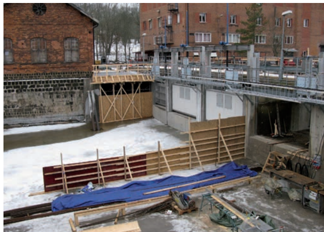
Fagersta under ombyggnad
