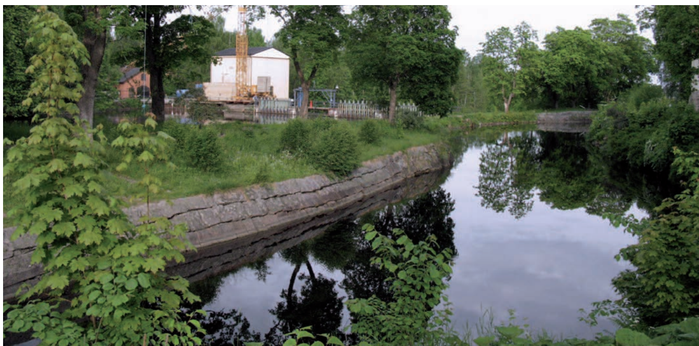
Strömsholms kanal vid Västanfors kraftverk
