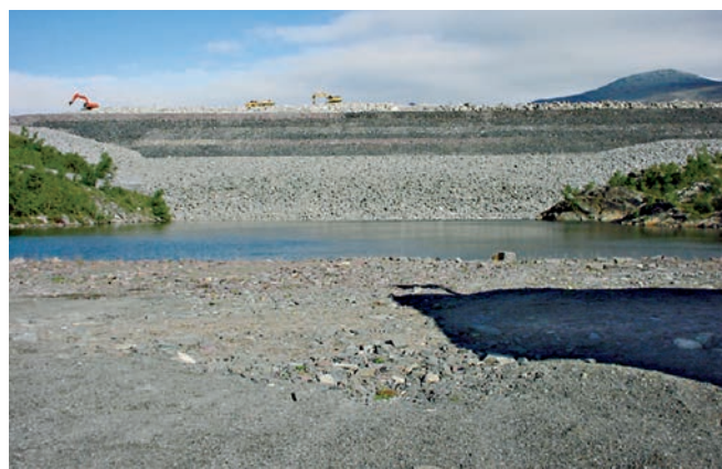
Suorvadammen som dämmer upp regleringsmagasinet Akkajaure i Stora Lule älv.
