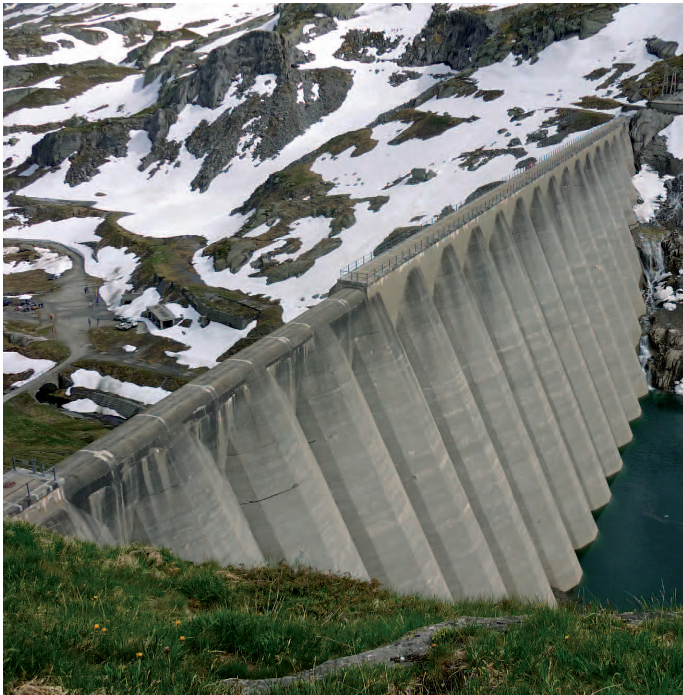
Lucerendo lamelldamm uppströms sida
