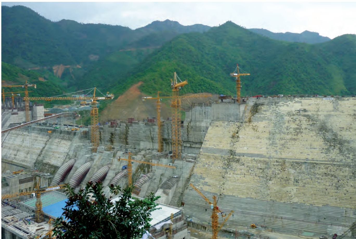
Son La, betongen klädd med skyddsplattor för långsammare efterhärdning.
