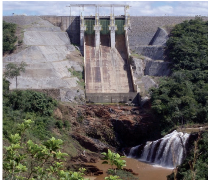
Från technical studytour till HPP Queimado med tillhörande damm. Foto: Åke Engström.
