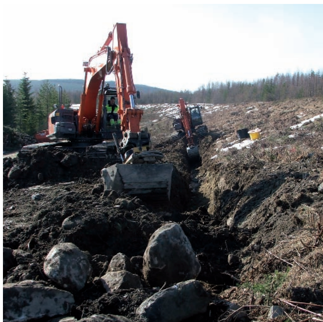
Schaktning för förläggning av optisk fiber vid Ledinge kanaldamm.
