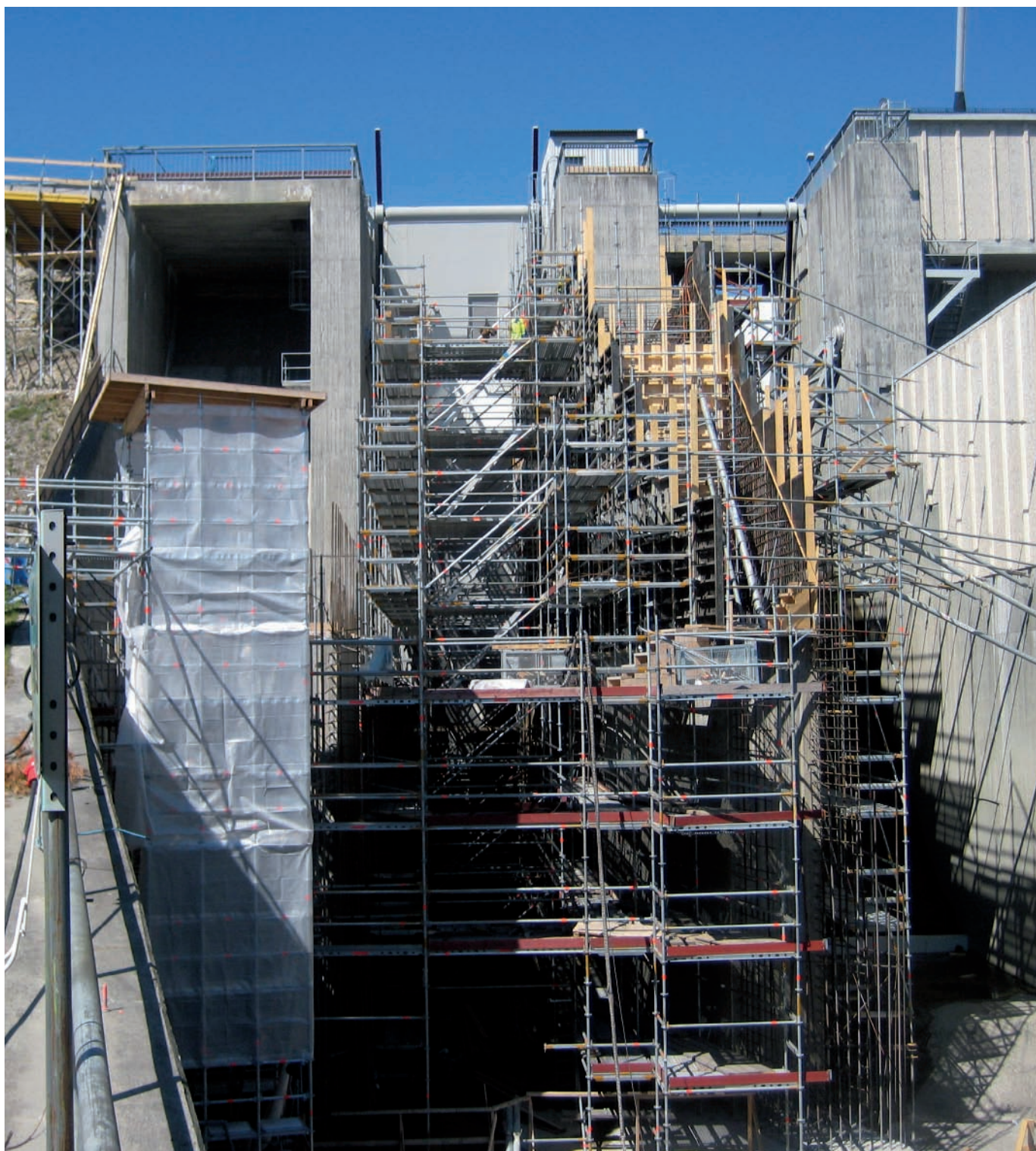
Utskovspartiet sedd nedströms ifrån. Från vänster i bild syns hävertutskovet, de två ytutskoven och därefter kraftstationen. Formsättning för förlängning av utskovspelaren mellan ytutskoven pågår.
