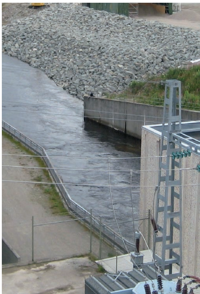
Utloppskanalen. I mitten på bilden är det nya erosionsskyddet längs kanalsidan under utläggning, och strax uppströms om detta syns slutet på ledmuren (ännu ej höjd). I förgrunden kraftstationen.
