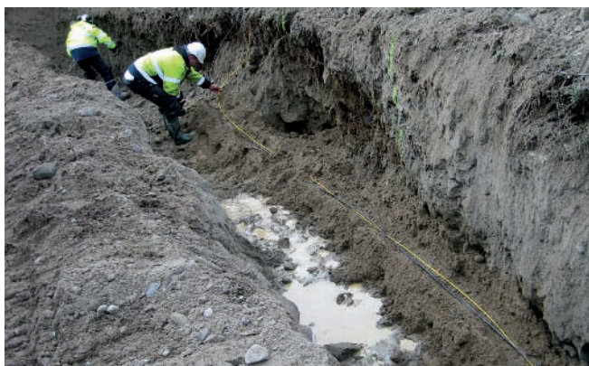
Förläggning av optisk fiber (gul) samt signalkabel.
