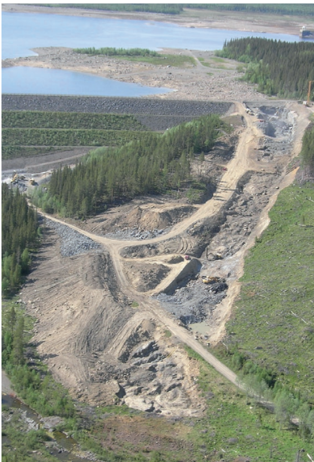
Pågående ombyggnadsarbeten för att förse Håckrendammen med ett nytt utskov och därigenom ytterligare höja säkerheten. (Foto: Vattenregleringsföretagen, 2006)
