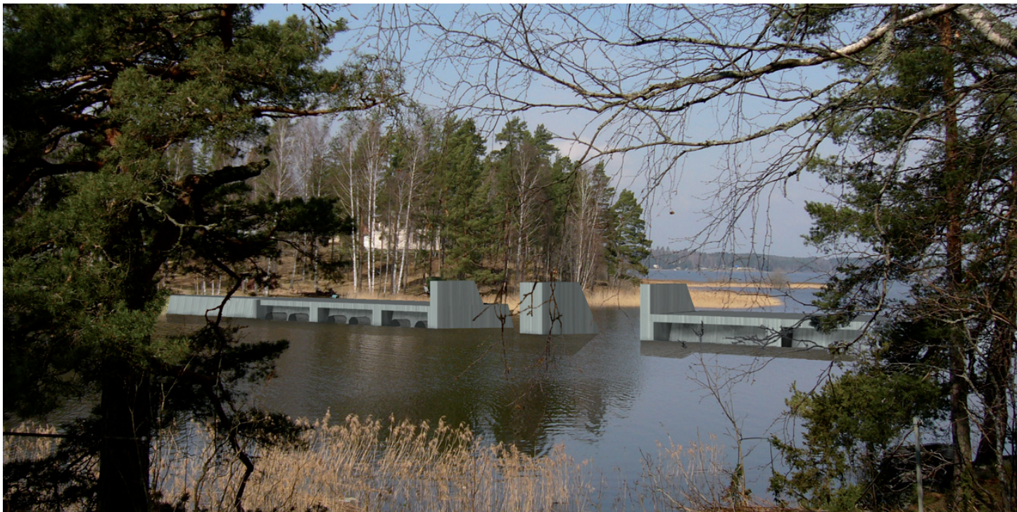
Fotomontaget visar den planerade huvuddammen sedd från Glafsforden. Betongkonstruktionen har två öppningar för sjöfart. Pumpstationen är belägen i dammdelen till vänster i bilden.
