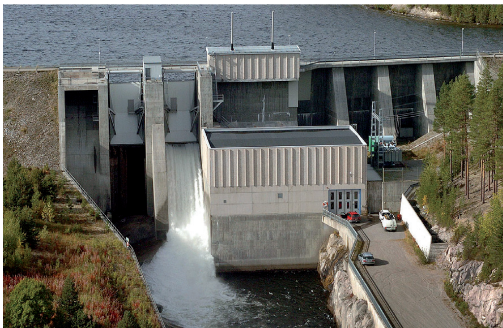
Pilotprojekt för utveckling av samordnad beredningsplanering för dammbrott som bedrivits i Ljusnan sedan år 2003 har nu avslutats. Läs om projektet på sid 3. Bilden föreställer kraftstationen Halvfari. Foto: Fortum.
