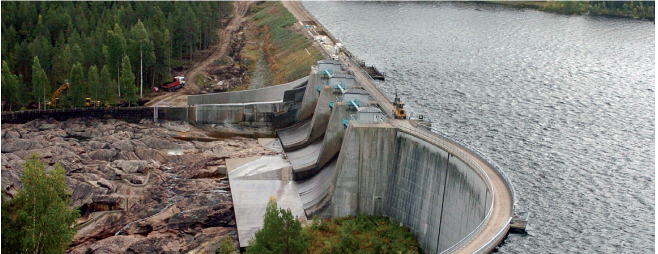
Krokströmmens kraftverk i Ljusnan. Foto Fortum.
