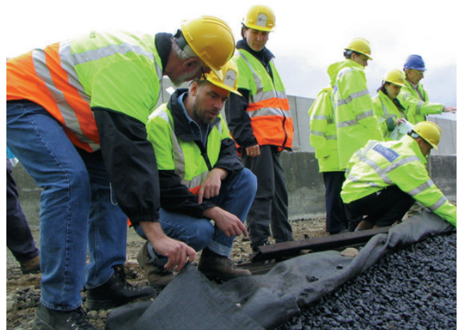
Bilderna visar utläggning av geotextil och Open Stone Asphalt på slänterna av Dalwhinnie Dam.
